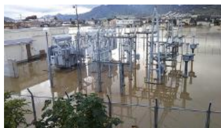
水没した変電所（長野県千曲市）
