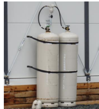
LPガス容器の設置例
