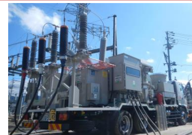
移動用変圧器による復旧（長野市）2
