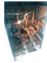
水没したポンプ
