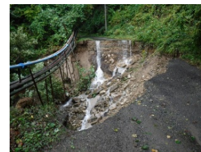
崩落した道路
