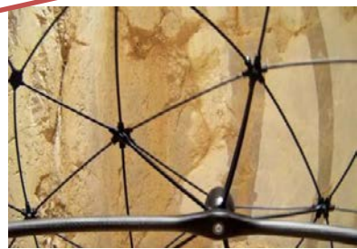
ドローンにより撮影した立坑壁面
