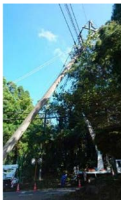
倒木・飛来物による電柱損壊
