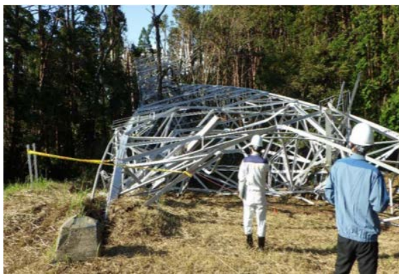
転倒した鉄塔
