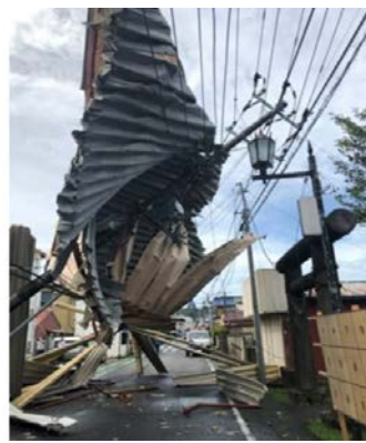
倒木・飛来物による電柱損壊
