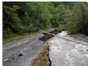
倒壊した電柱
